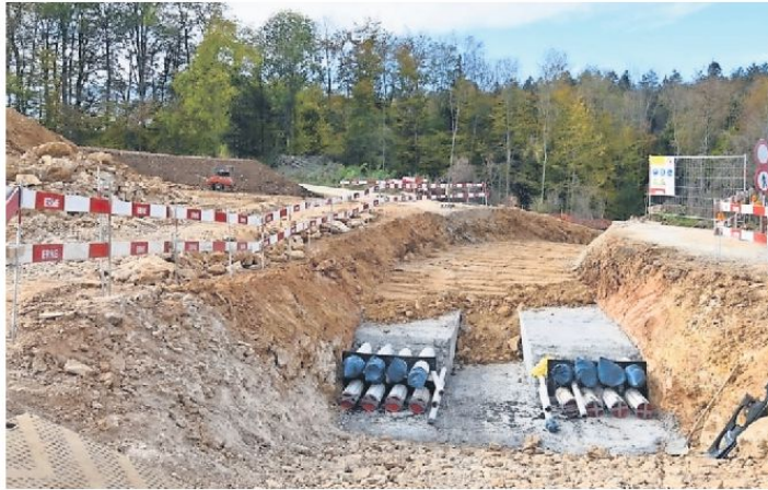
So etwas gab es in der Schweiz noch nicht: Am «Gäbihübel» auf dem Bözberg wird eine unterirdische 380-kV-Leitung gebaut. zvw
